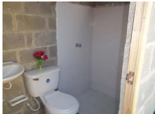
Fotografía 4: Modelo de baño construido por el programa para los beneficiarios de las Conexiones intradomiciliarias
